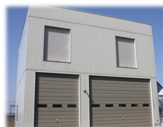
防災車庫棟完成
